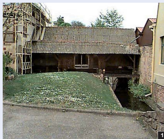
▲ La bâtisse et ce qu'il reste du passage de l'eau.
