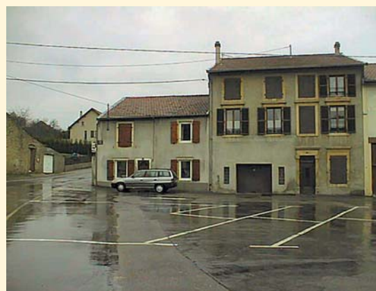
▲ De l'enrobé qui couvre tout, il n'apparaît que le marquage des places de stationnement.
