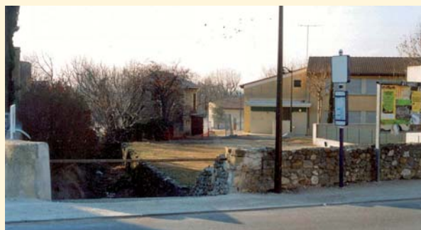
▲ Le fossé d'écoulement des eaux pluviales offre un passage allant de la RD n° 56 près du temple jusqu'au terrain devant l'école.
