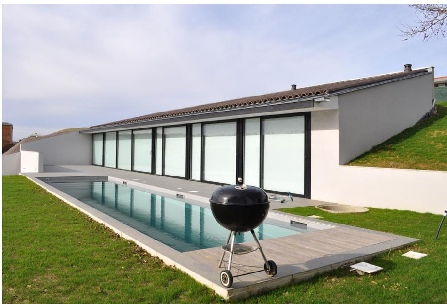
Construite sur un terrain avec une forte déclivité, la maison est encastrée parallèlement aux courbes de niveau et la toiture posée au plus près du sol et de sa pente. La partie Nord de la maison se trouvant ainsi enterrée, est éclairée par une verrière. A l'intérieur, la pente subtile et douce du plafond, la lumière zénithale et la monochromie des murs et du plafond donnent à l'espace un caractère apaisant et renforcent la sensation de cocon sous la terre.
